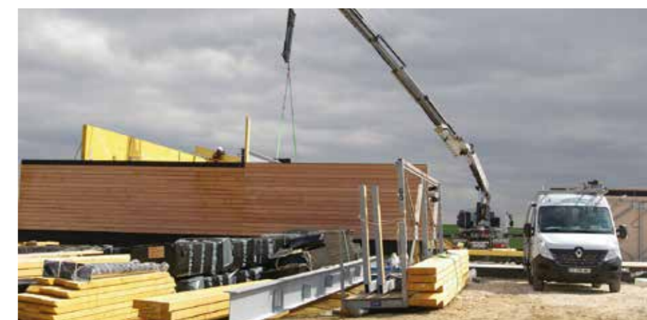
La nouvelle école en chantier
